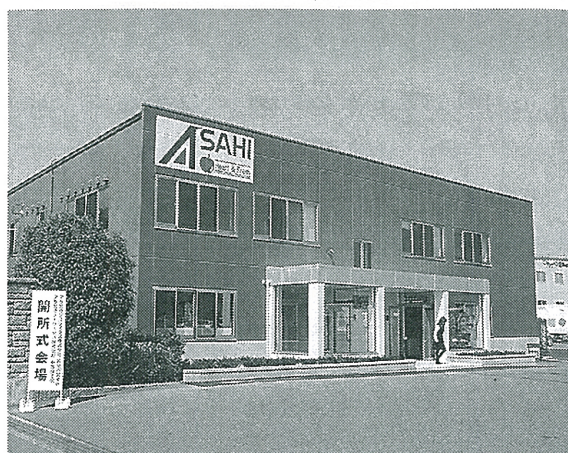
新滑川営業所、アサヒオートサービス(株)新工場の 共同新社屋。燃料備蓄も増強した
